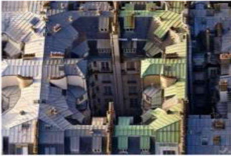
On distingue le zinc (gris clair) de l'ardoise (gris foncé). Les toits verts eux sont en cuivre. © Xavier D'Abrigeon
