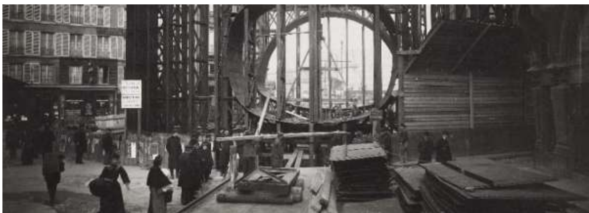
Service technique du métropolitain de Paris. Construction de la ligne 4 du métro de Paris
